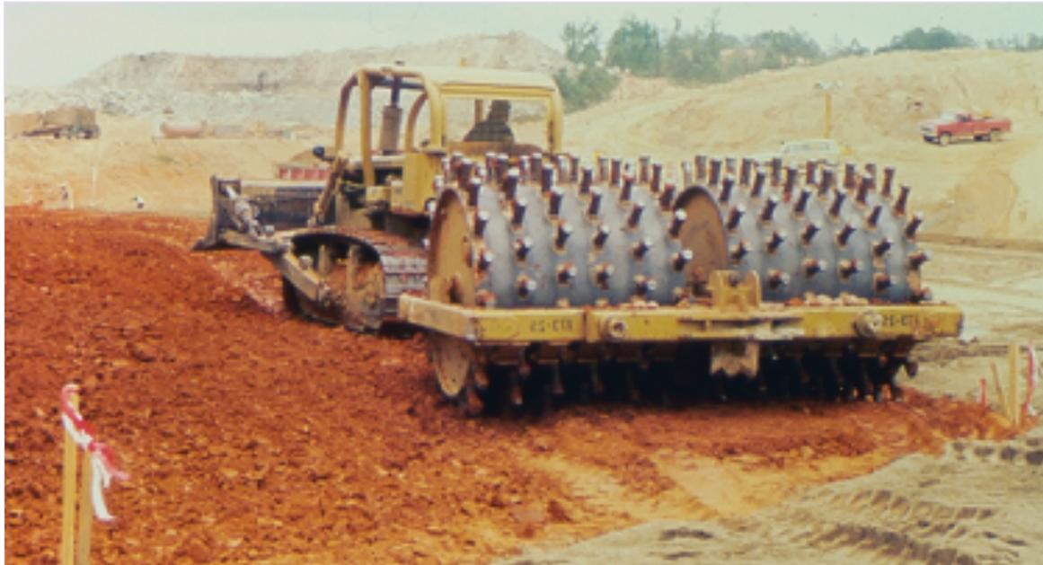
Los pisones en los tambores pata de cabra penetran a través de la capa superior y realmente compactan la capa debajo. Cuando un pisón emerge del suelo, avienta o levanta el material. El resultado es una capa de material suelto en la parte de arriba. Cuando se esparce más relleno, la capa superior es levantada y la capa anterior se compacta. Un compactador de pata de cabra realmente compacta de abajo hacia arriba.
